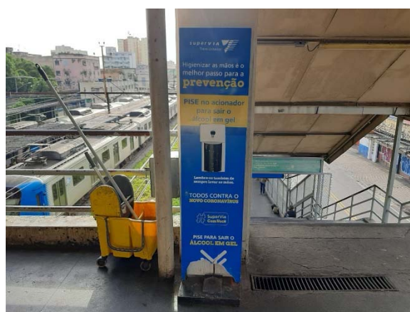
Figura 6-18 – Estação Nova Iguaçu – 18/12/2020
